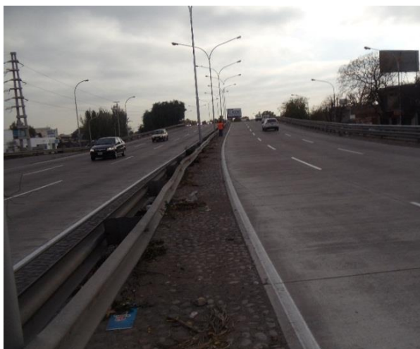
Foto: Defensas metálicas en cantero central a reemplazar por defensa tipo New Jersey o medio New Jersey
