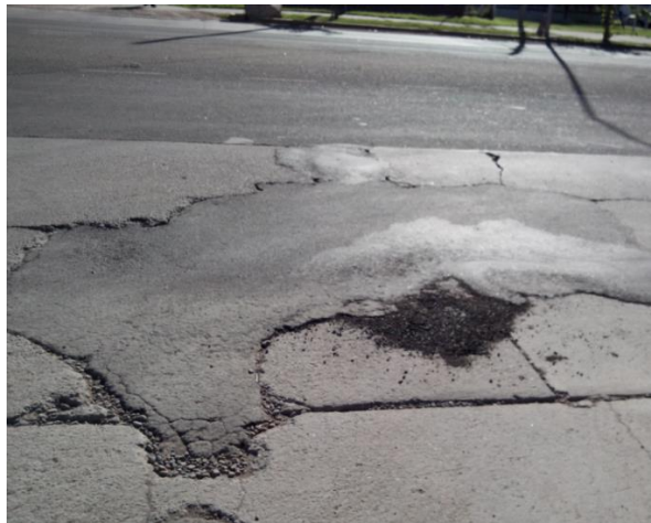
Foto: Losa a reemplazar (reconstrucción de losa)
