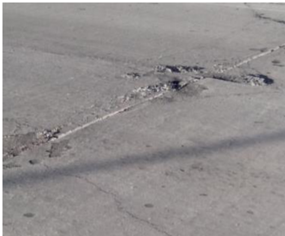
Foto: Losa a reparar (Reparación a espesor parcial)
