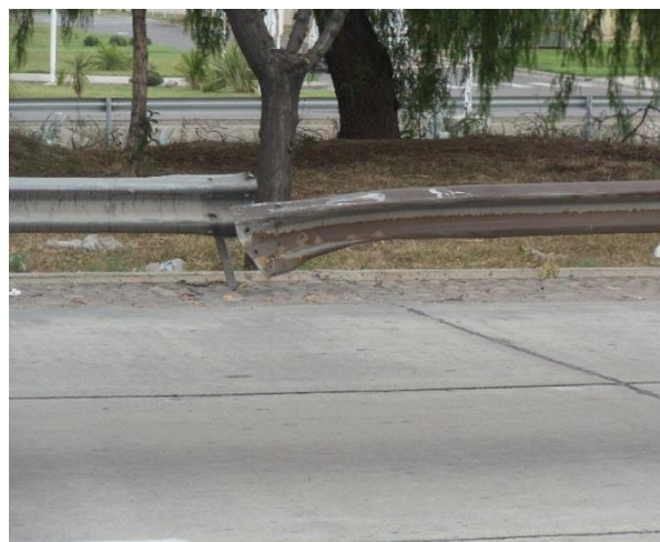
Foto: Defensa metálica dañada a reemplazar
