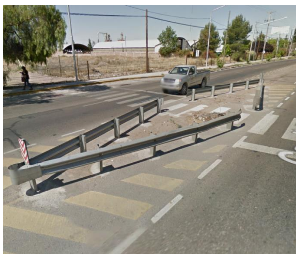
Foto: Defensas metálicas a reemplazar por Defensas tipo Medio New Jersey
