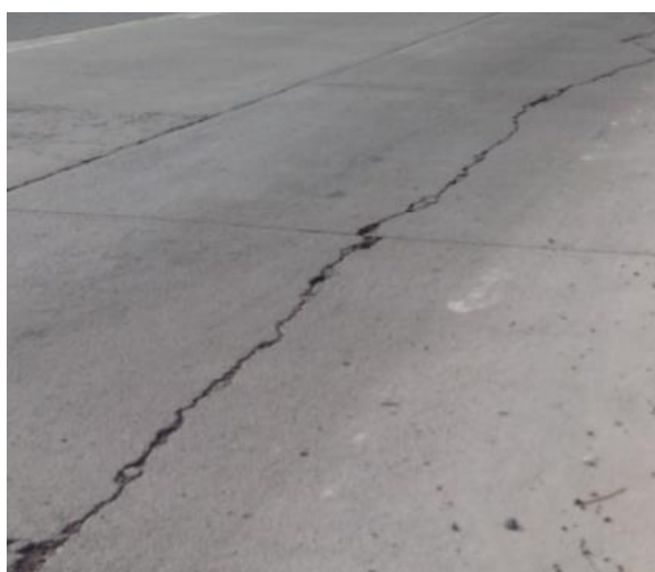
Foto: Fisuras a Reparar por costura cruzada
