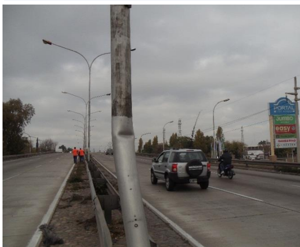
Foto: Columna de AP dañada a reemplazar
