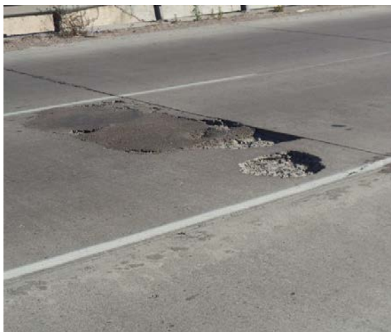
Foto: Losa a reparar (Reparación a espesor total)
