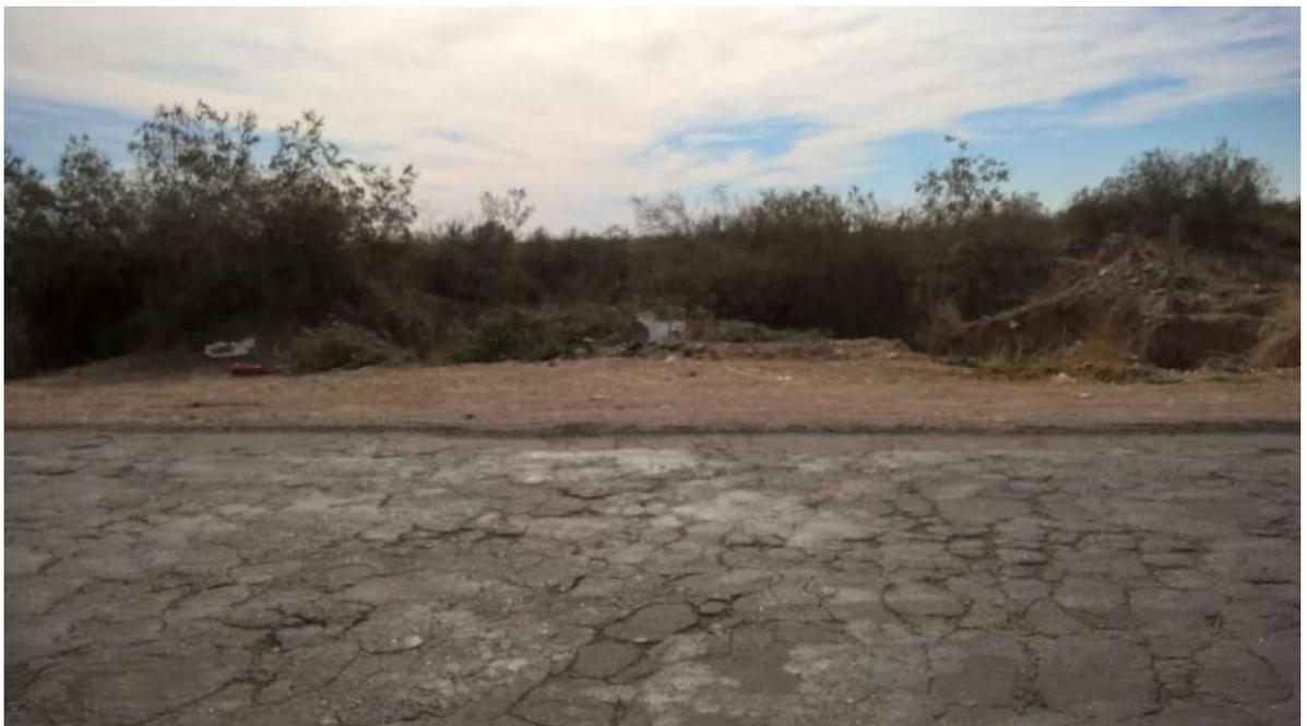
**Foto:** estado de deterioro de la calzada
