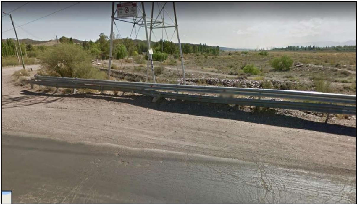
**Foto:** Barandas de contención sin mantenimiento.
