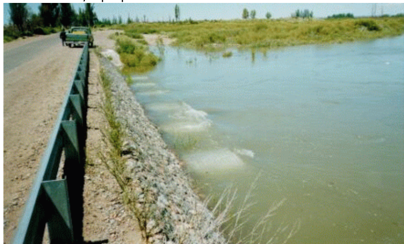
Vista desde margen izquierda, aguas arriba año 2001
