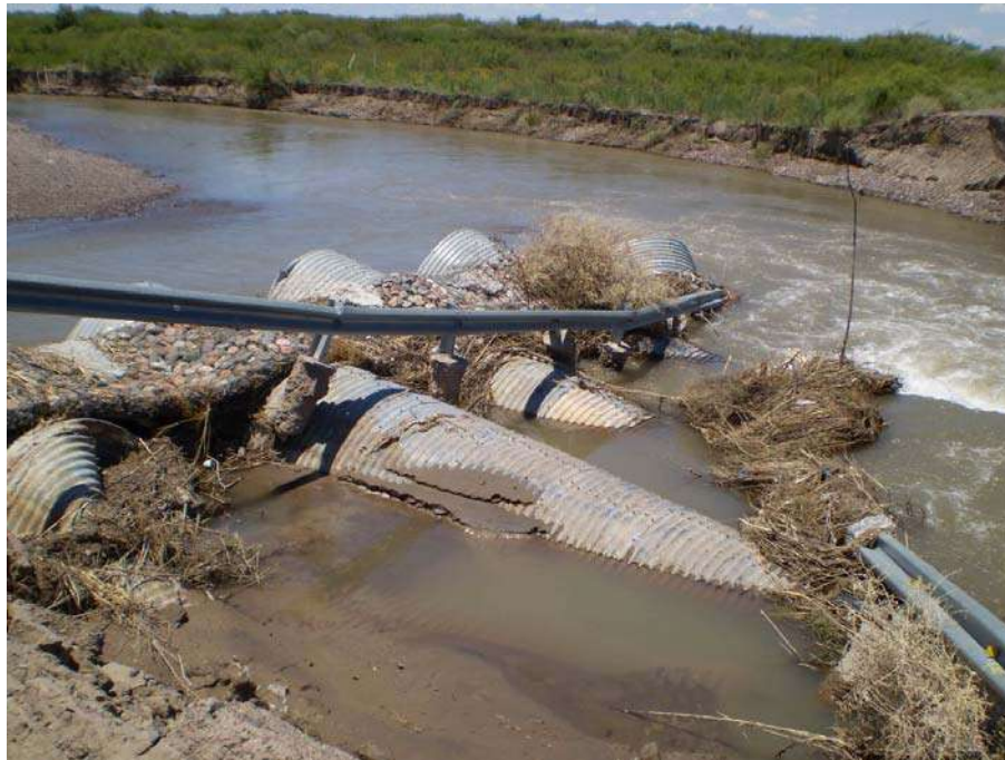
Colapso de la obra hidráulica, enero del 2009
