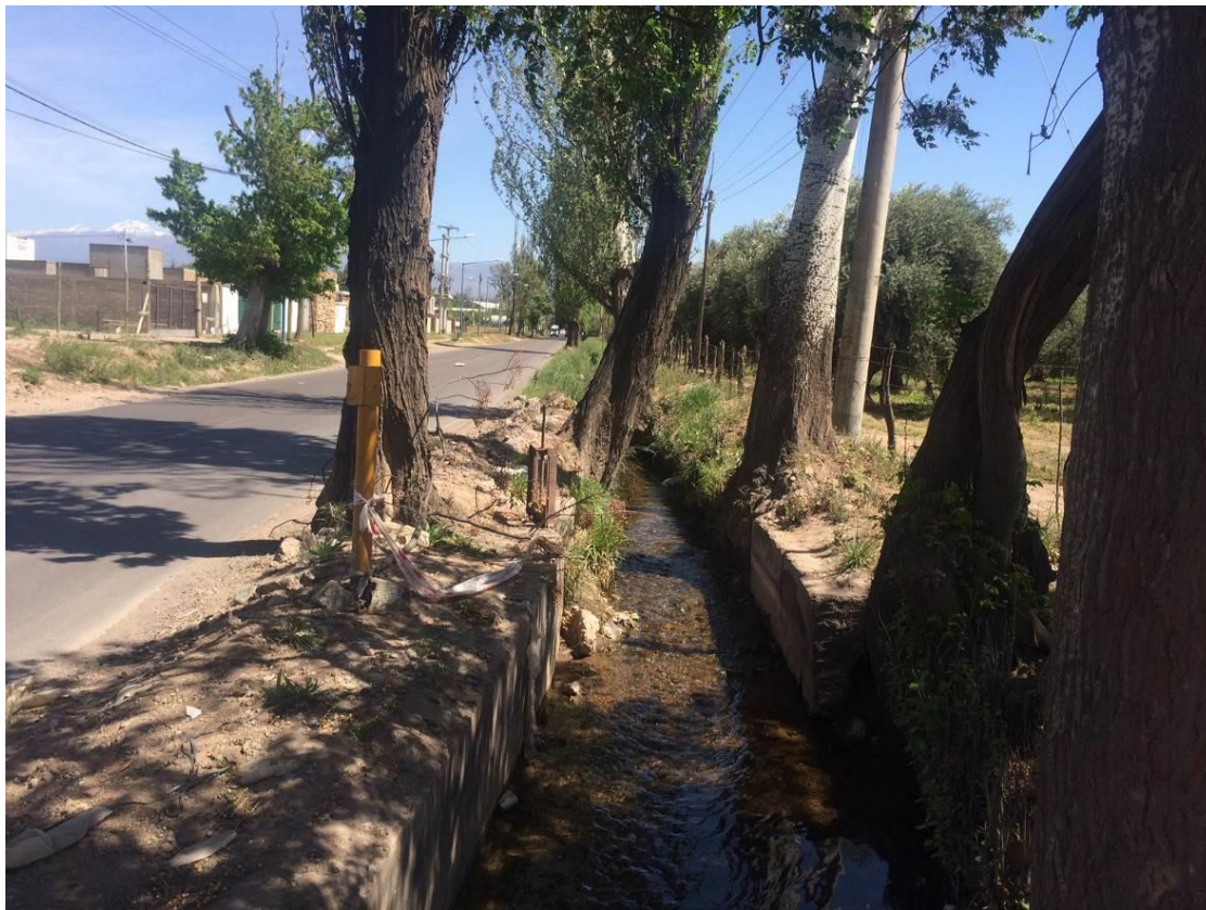
FOTO: ANCHO DE CALZADA ACTUAL Y CANAL COSTADO NORTE EN CALLE ALSINA
