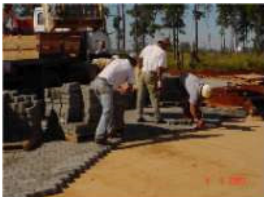
Colocación manual de los adoquines sobre la capa de asiento de arena
