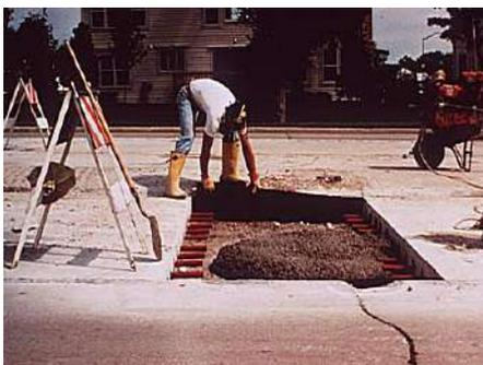
Para reparaciones menores a 4,50 m, es preferible la colocación de un material que evite la adherencia del hormigón con el hormigón del carril o banquina lindante (madera terciada con pintura asfáltica, membrana asfáltica u otros, de aproximadamente 5 mm de espesor). El material separador se colocará en todo el ancho y espesor de la zona de contacto. Esto
