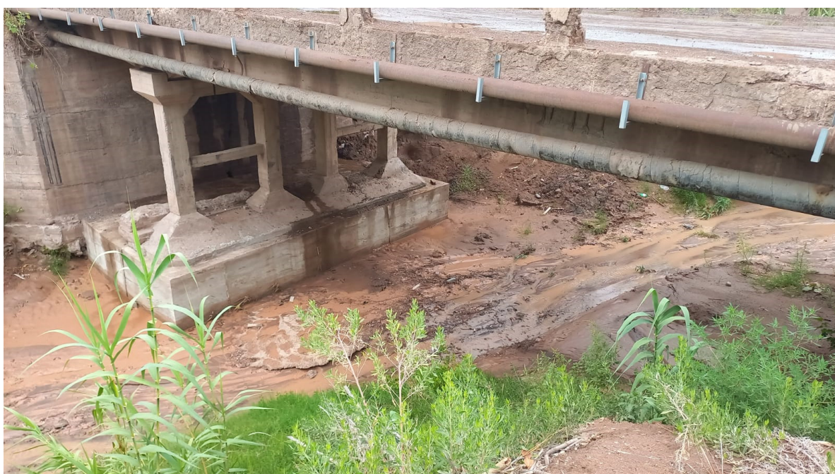
Foto N° 3: Protección parcial pila margen derecha
