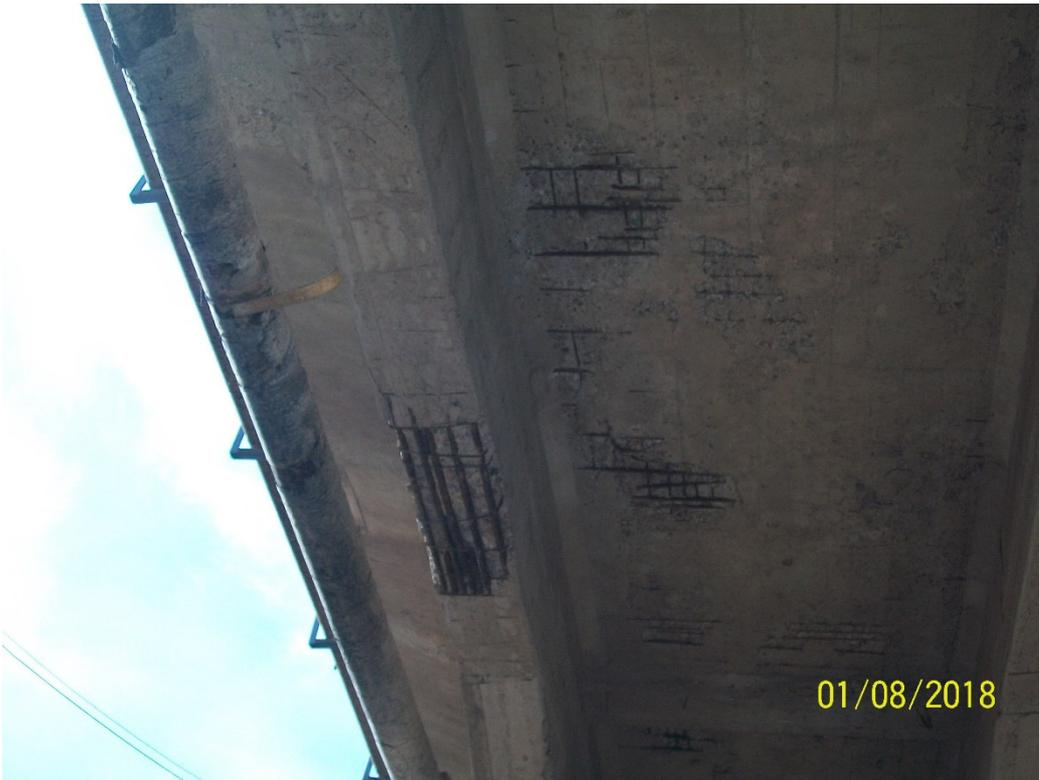
**Foto N° 4: Estado de carbonatación del hormigón y exposición de armaduras con reducción de sección de acero en tablero y vigas principales.**
