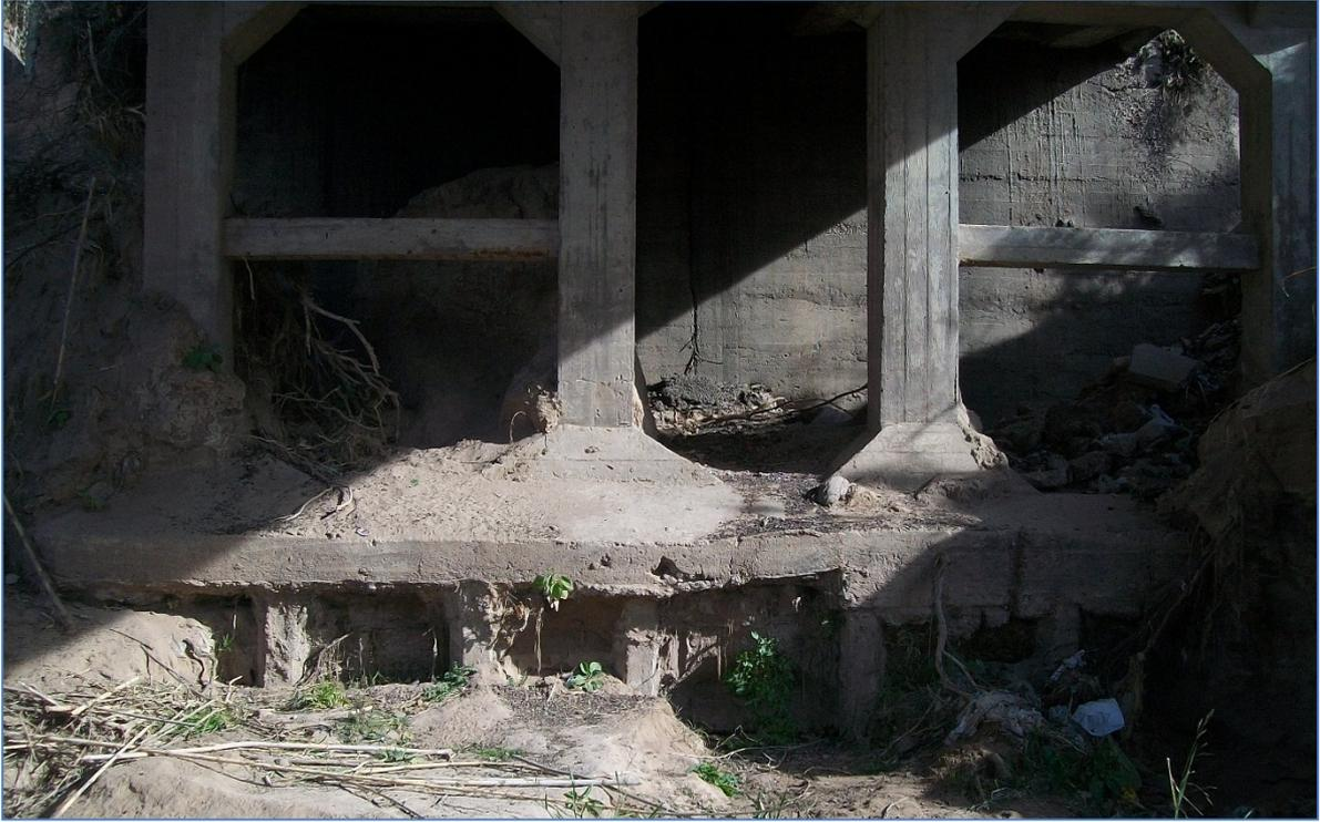
**Foto N° 2: Erosión en pilas (en la actualidad protegida parcialmente – ver Foto N°3)**
