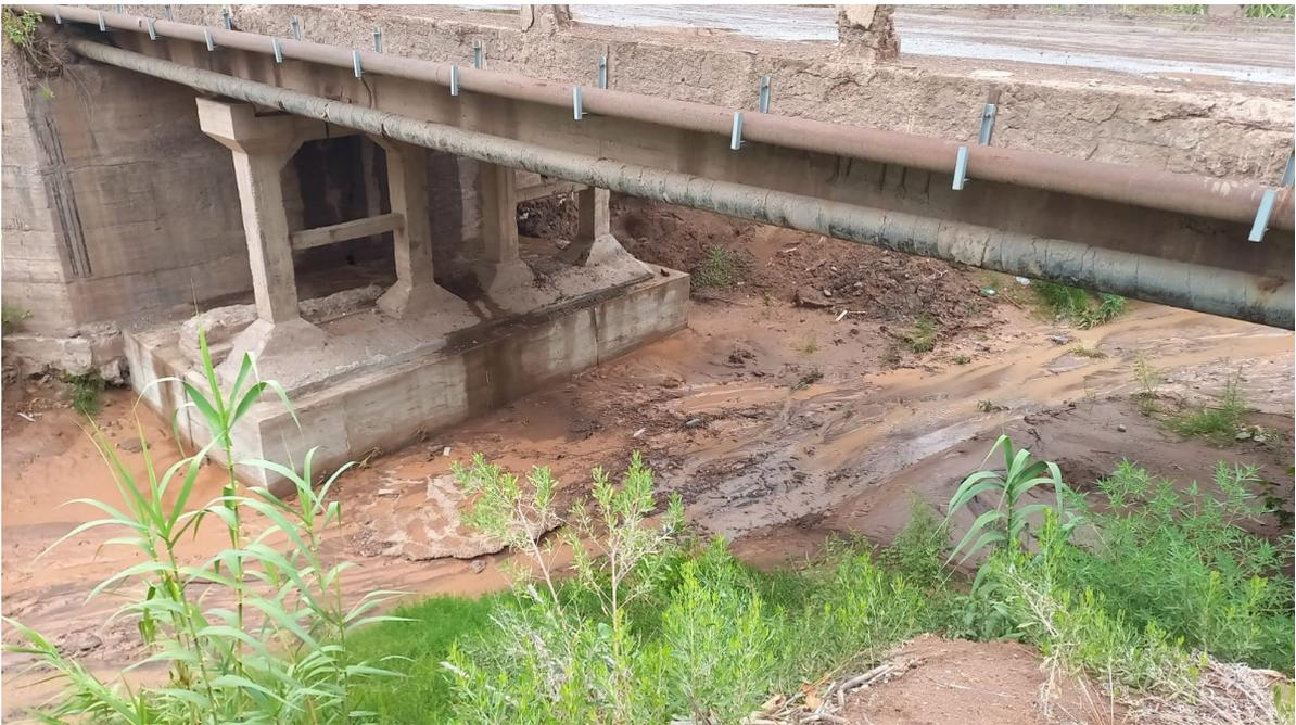
**Foto N° 3: Protección parcial pila margen derecha**
