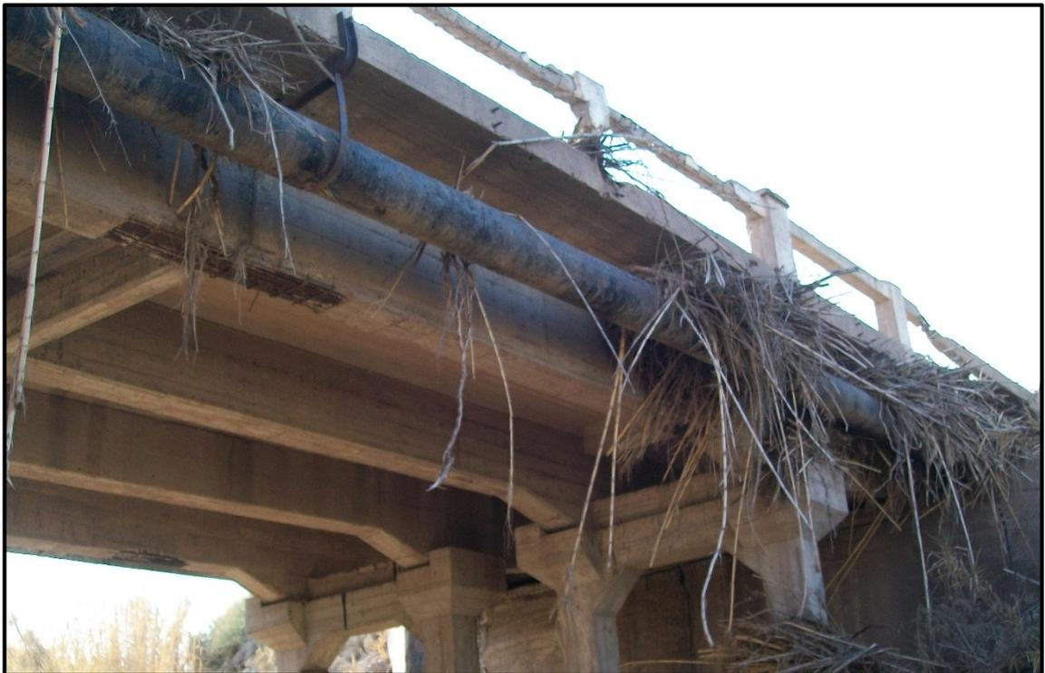
**Foto N° 1: Obstrucción de material flotante por insuficiencia de sección hidráulica, alcanzando la altura de las barandas de protección vehicular, se puede observar que el mismo ha sido sobrepasado por el paso de crecidas.**
