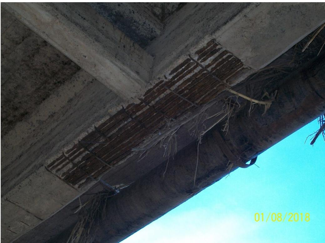
**Foto N° 5: Grave situación estructural por pérdida de recubrimiento de armaduras, con reducción de sección de acero en vigas principales.**
